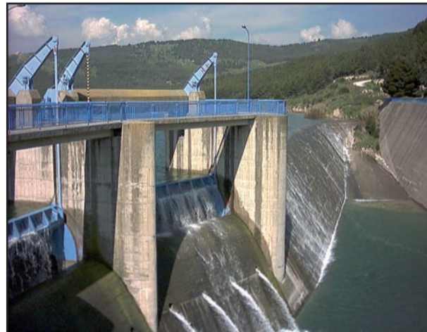
Uno dei fiori all'occhiello dell'Intesis: il sistema di supervisione e telecomando della diga di Occhito
